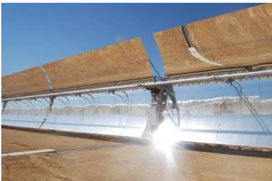
Figura 4.11.6. Detalle de campo solar de una central cilindroparabólica
