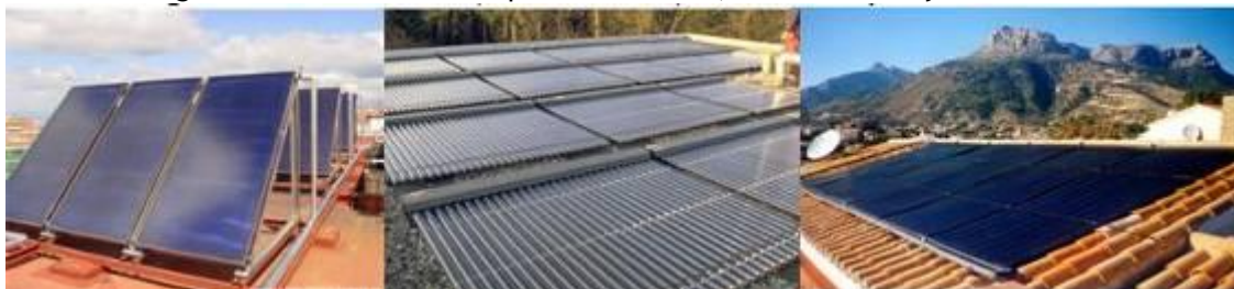
Figura 4.10.12. Colectores planos vidriados, tubo de vacío y no vidriados
