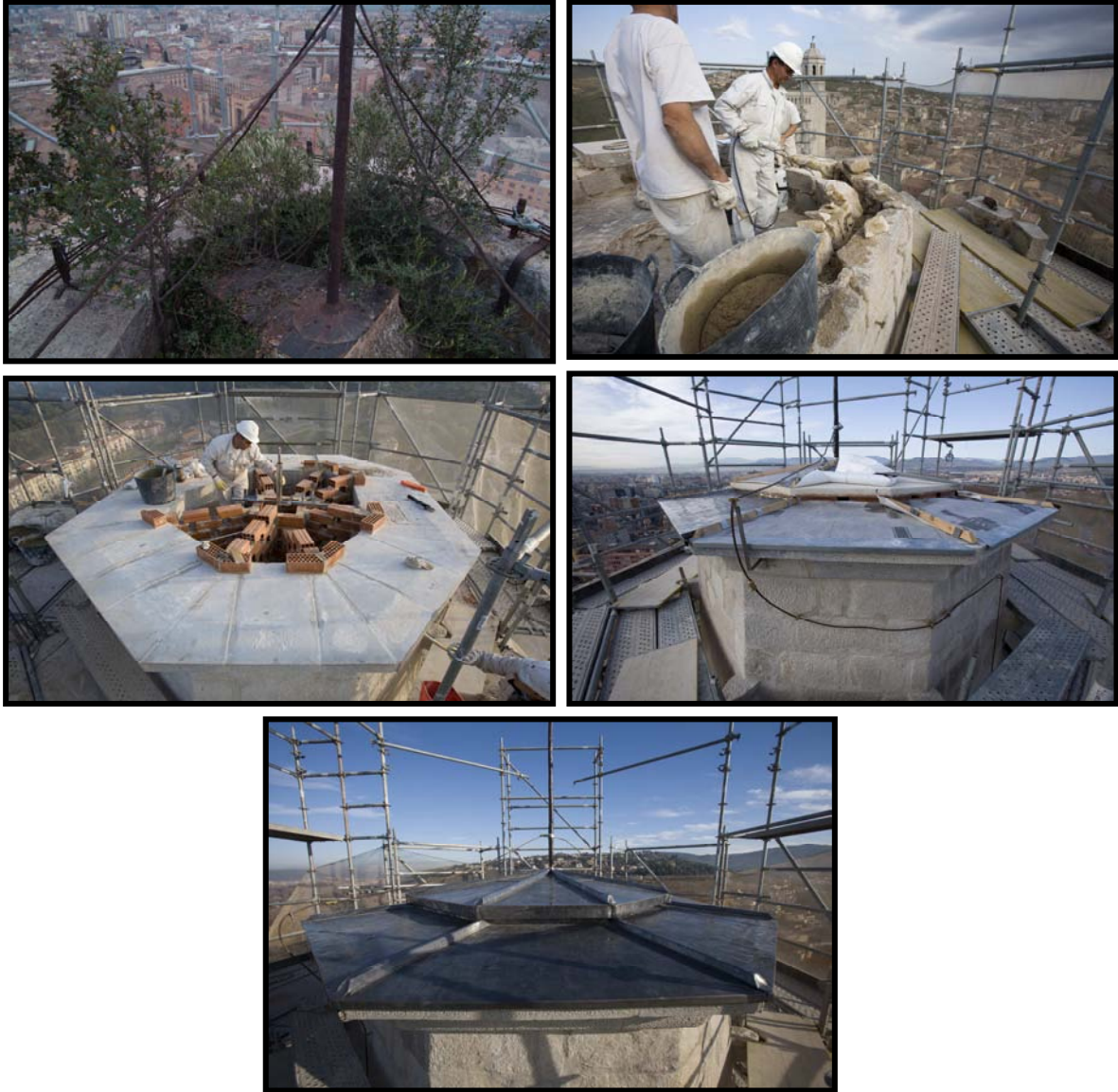
FOTOGRAFIA N°38, 39, 40, 41, 42 I 43: COBERTA DE L'AGULLA
