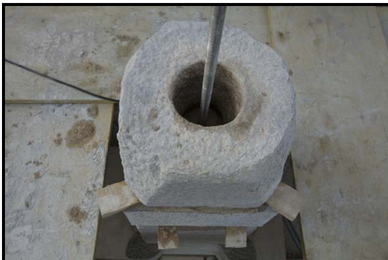
FOTOGRAFIA N°32: REPOSICIÓ DE PINACLE AMB BARRA D'ACER
