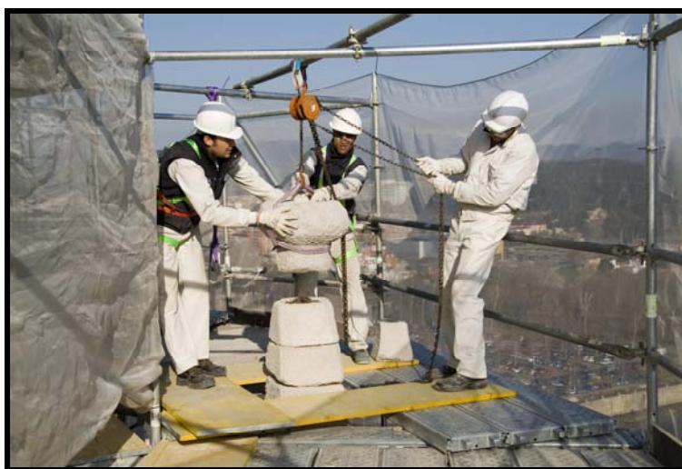
FOTOGRAFIA Nº31: DESMUNTATGE DE PINACLE
