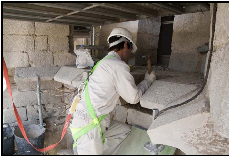
FOTOGRAFIA Nº25: TRANEIG DE LA PEDRA
