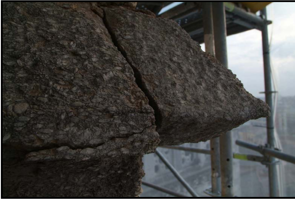
FOTOGRAFIA N° 11: FRACTURA DE LA PEDRA
