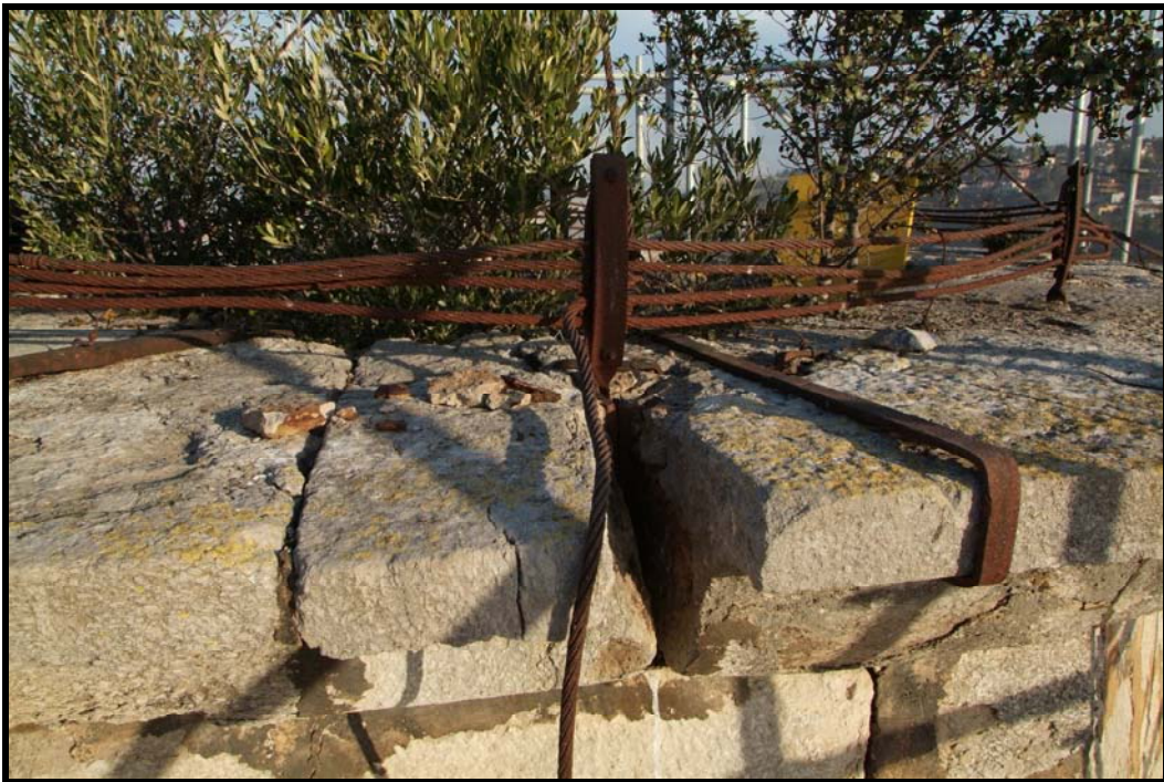
FOTOGRAFIA Nº 10: FRACTURA PER ELEMENT FERROS
