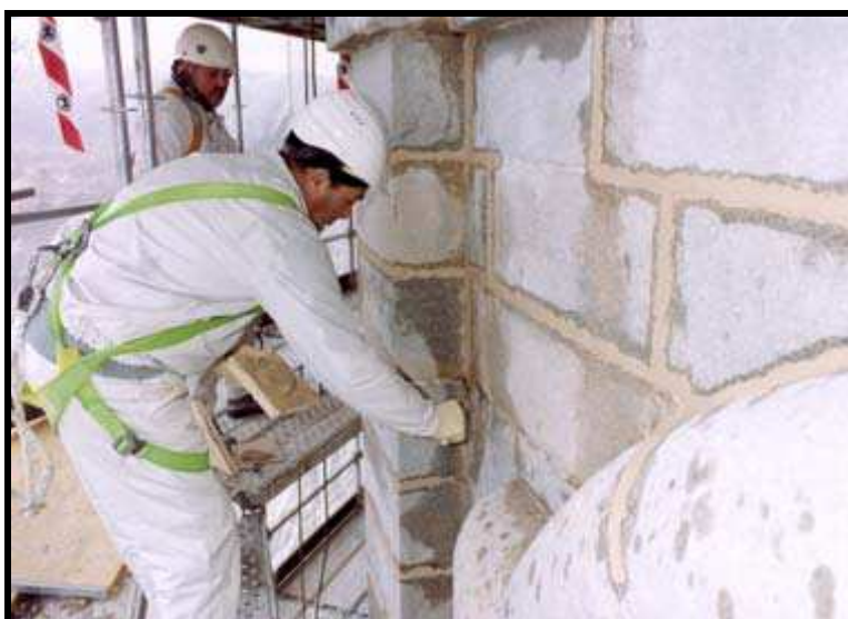
FOTOGRAFIA Nº20: TRACTAMENT DE JUNTES
