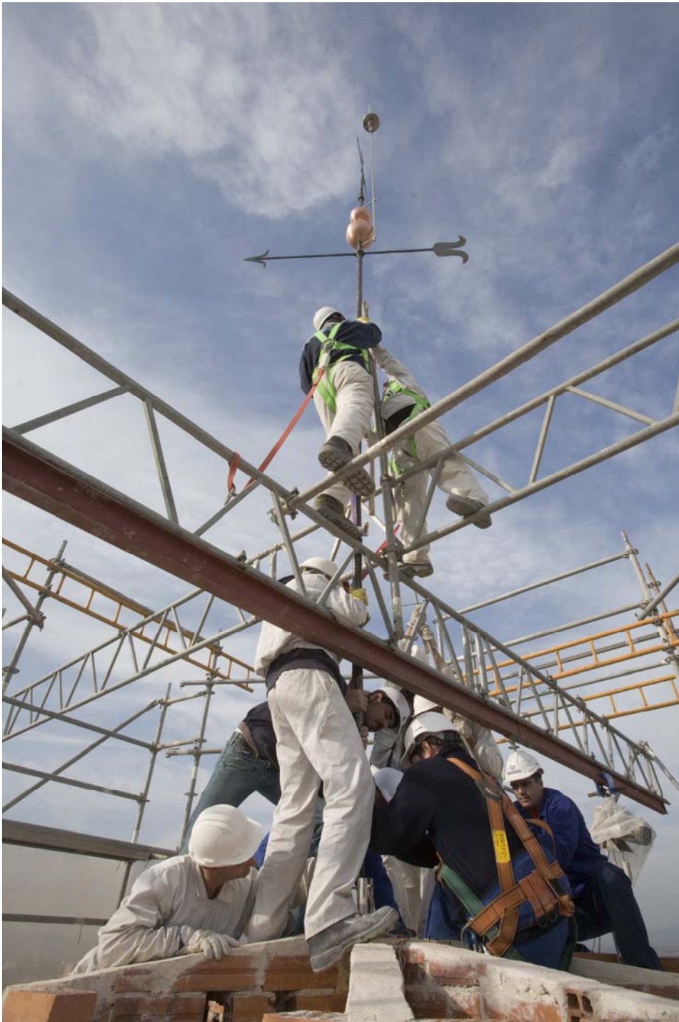
FOTOGRAFIA Nº47: PARALLAMPS SOBRE VELETA RESTAURADA
