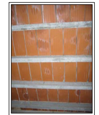
H-32. Sostre bigueta formigó.
