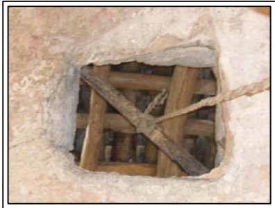
H.41. Coberta torre.
