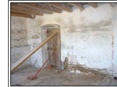
H 30. Disgregació en tapiat.
