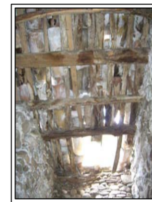
H-14. Coberta enderrocada.
