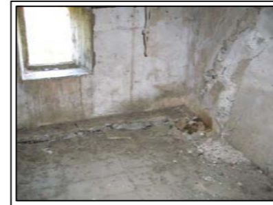
H-37. Enfonsament del paviment.
