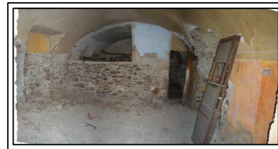
H-1. Vista general.
