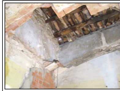
H-23. Part de volta enderrocada.
