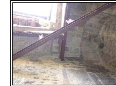
Reforç perfils metàl·lics sota escala exterior.
