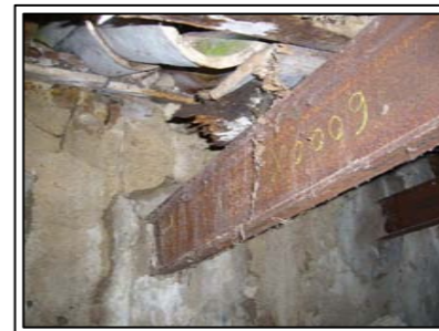
H-40. Bigueta metàl·lica oxidada.
