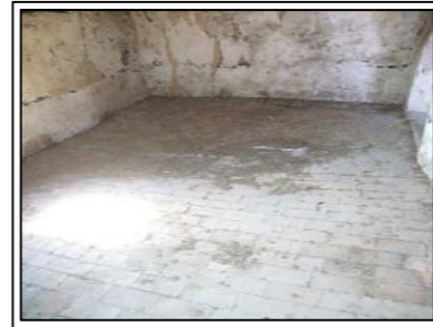
H-34. Enfonsament del paviment.
