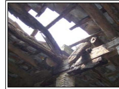
H-12. Coberta enderrocada.
