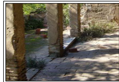
H-22. Enfonsament base pilar.
