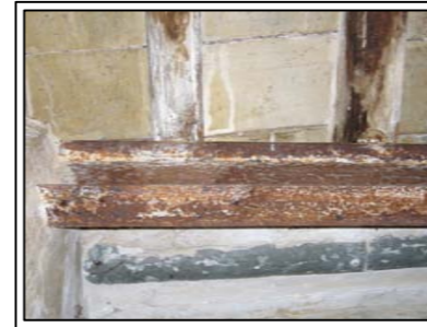
H-27. Bigueta metàl·lica oxidada.
