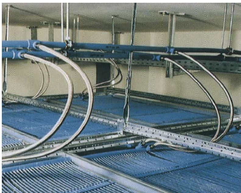
Fig.3.3. Exemple falç sostre radiant amb tubs capil·lars
