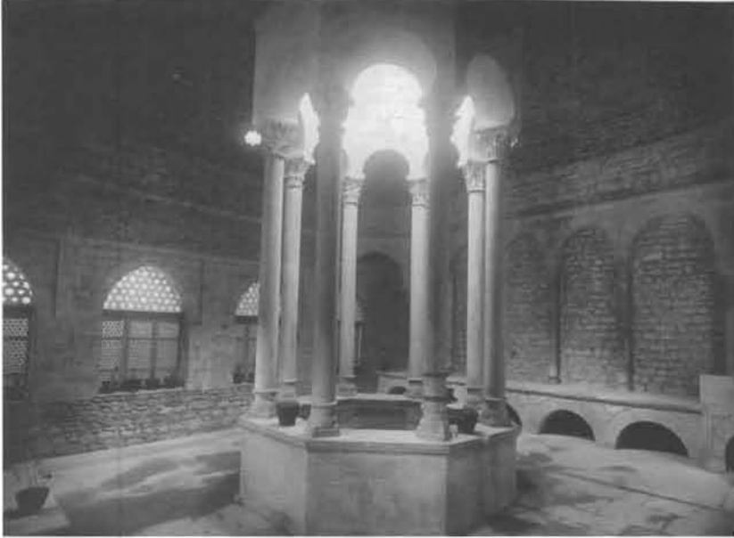
Figura 2 - L' Lapodyterium o frigidarium és la sala més ben conservada, amb la seva volta construïda de pedra tosca intacta, i la piscina i la claraboia on es concentra la major part de la decoració.
