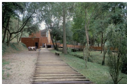
Figura 4. Pont que travessa el riu Serinyadell i edifici de recepció. S'hi pot veure el primer passeig central fet amb travesses de tren que una riuada del Serinyadell s'endugué a la tardor de 2005.
