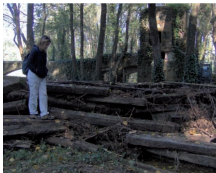
Figura 16. A la tardor de 2005, una riuada s'endugué les travesses que formaven el pas-seig central i les acumulà riu avall, al nord del Parc.
