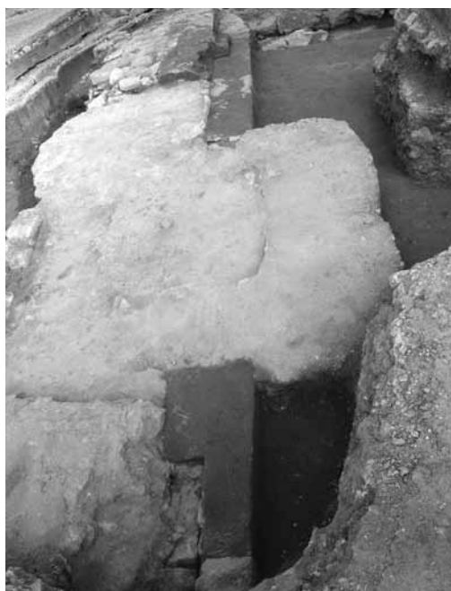
Figura 15. Vista lateral izquierda del muro de sillería con pilastras de la primera plaza pública al que se superponen las cimentaciones para la columnata relacionada con el segundo templo y posteriormente el chalcidicum de inicios del Imperio.
