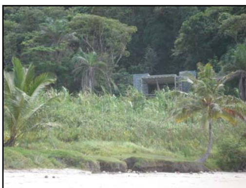
Fotos 6 i 7: Vistes de la construcció del Warapurú des de la platja de Engenhoca. Font pròpia.
