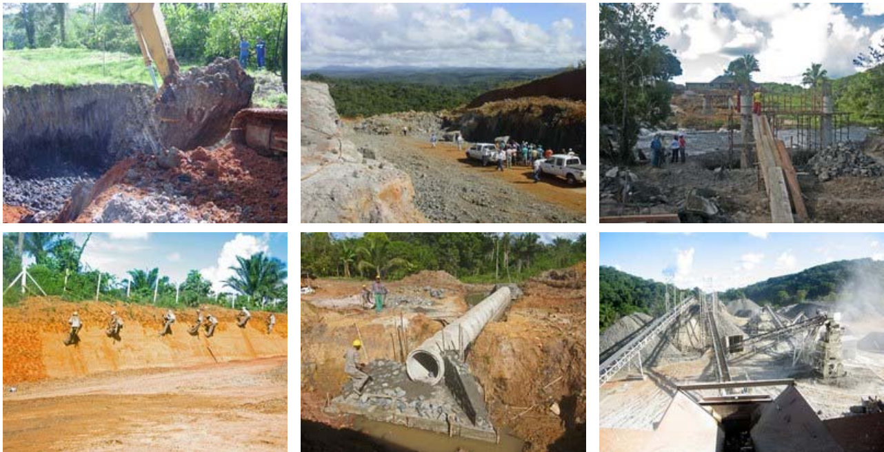
Foto 8: Fase de construcció de la carretera BA001, al llarg del seu recorregut. Font Floresta Viva
