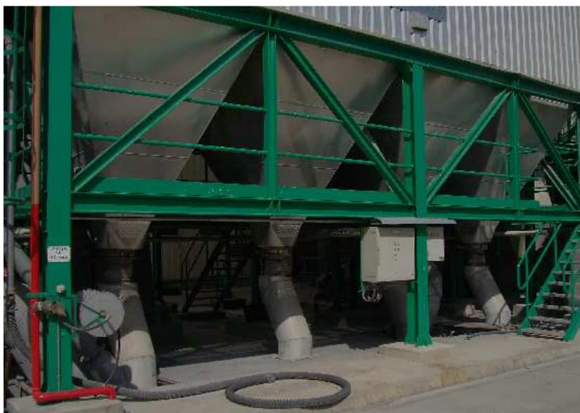
Fotografia del filtre de mànegues (Font: Jordi Bardagí)
