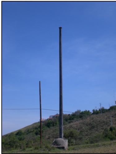
Imagen 203. El mástil en estado actual. Fuente: ViaNatura, 2008.
