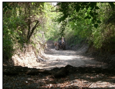
Imagen 146. Extracción de áridos en el río AntaYacu .Fuente: ViaNatura, 2008
