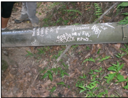
Imagen 189. Tubería grafitada. Fuente: ViaNatura, 2008
