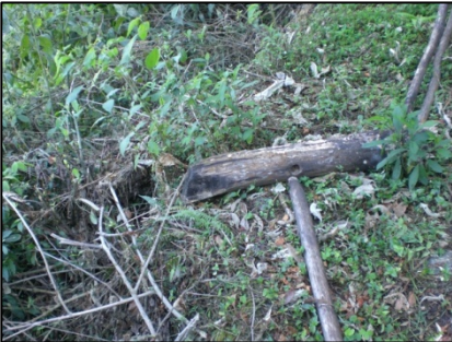
Imagen 132. Barandilla en mal estado. Fuente: ViaNatura, 2008
