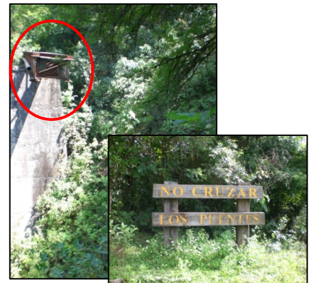
Imagen 187. Puente en mal estado. Fuente: ViaNatura, 2008
