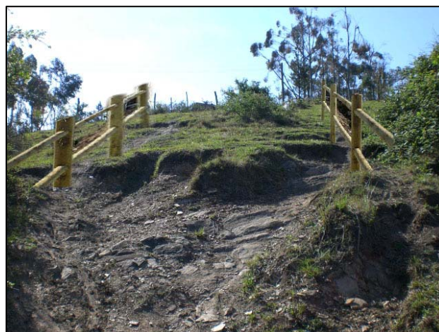
Imagen 213. zona con ejemplo de baranda. Fuente: ViaNatura, 2008
