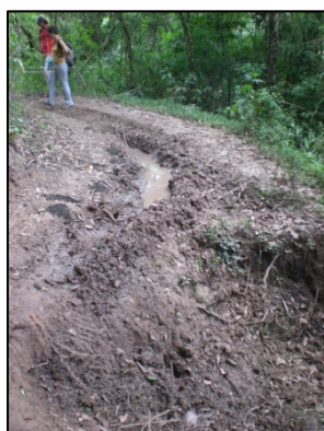
Imagen 164. Desprendimiento de Tierra. Fuente: ViaNatura, 2008
