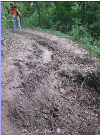
Imagen 243. desprendimiento del suelo. Fuente: ViaNatura, 2008
