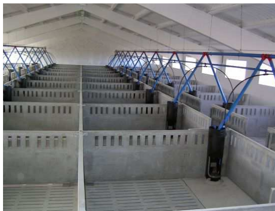
Figura 5.7. Divisions de tipus formigó armat (Mazana, 2014).
