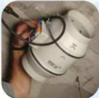
Realizar las conexiones
