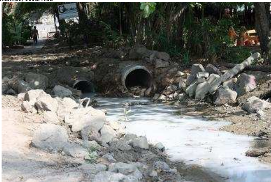
Fig. 17: desembocadura de aguas residuales en playa Tamarindo. (abril 2008)
